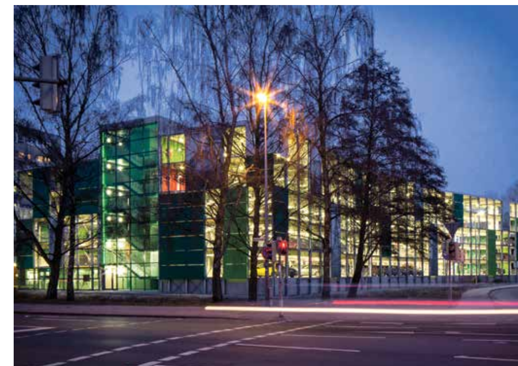
Auch im Dunkeln erstrahlt das neue City-Parkhaus und sorgt so für einen Hingucker in der Stadt.
