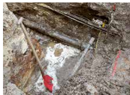
Tatkräftiger Einsatz von Mensch und Maschine: Schon innerhalb weniger Stunden konnte die Wasserleitung vollständig repariert werden.
