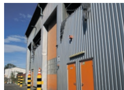
Dank der schnellen Reaktion der Feuerwehr konnten schlimmere Schäden an der Umschlaghalle verhindert werden.
