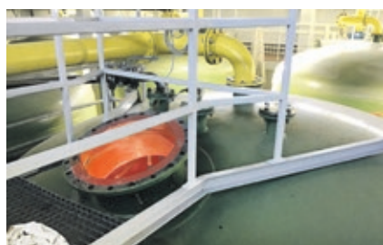
Im Wasserwerk Annenheide konnte ein Großteil der Sanierungsarbeiten bereits fertiggestellt werden.
