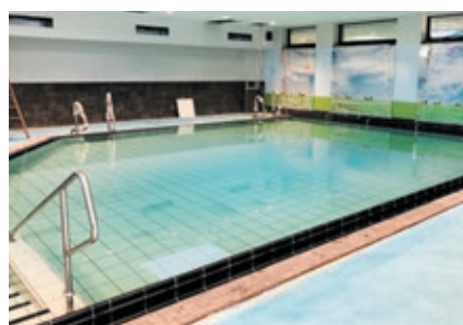
Sichtbarer Baufortschritt: Noch in diesem Jahr kann das neue Kursbecken öffnen.
