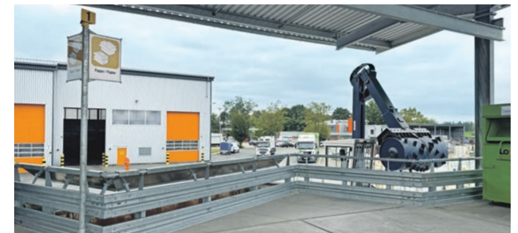
Die Abfallannahmestellen stehen allen privaten Haushalten in Delmenhorst offen.
