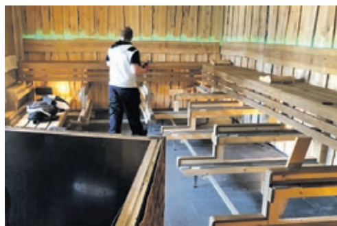
Während der Schließung fanden im Saunabereich anstehende Reparaturen statt.
