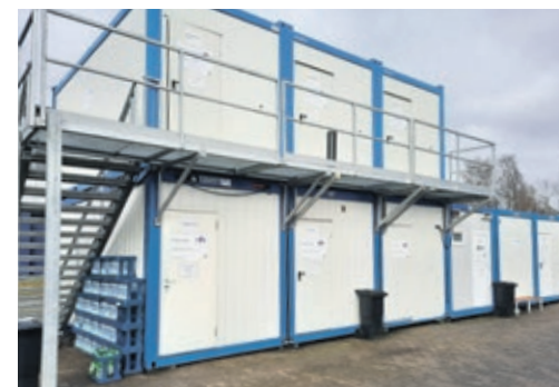
Auf dem Gelände der Abfallwirtschaft stehen Büro-Container bereit.
