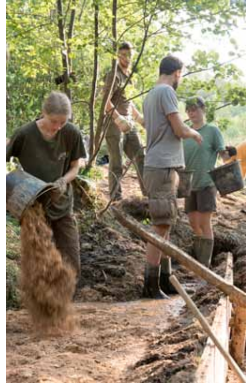
Verfüllen mit Sägemehl
