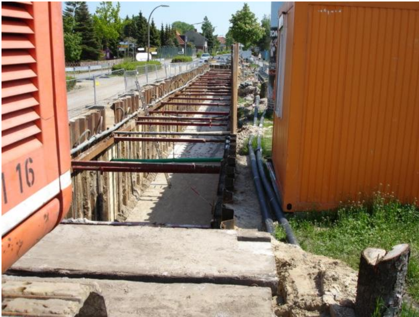
Für den Einbau des Stauraumkanals vorbereitete Baugrube
