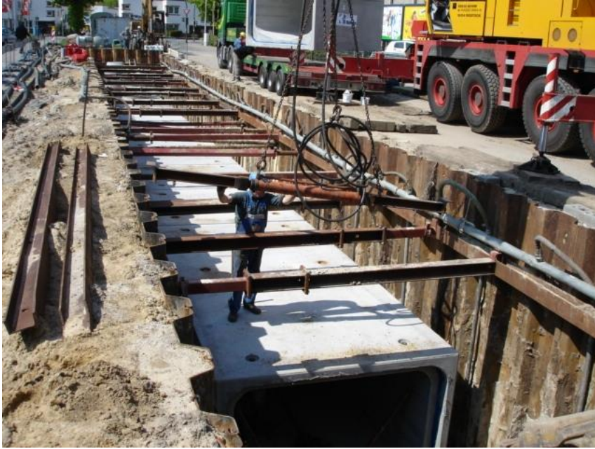
Bereits zu 50% fertiggestellter Stauraumkanal
