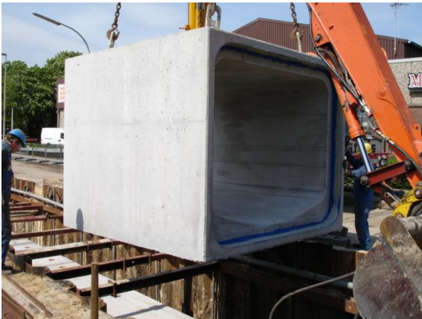
Einbau der per Schwertransporter angelieferten Betonfertigteile
