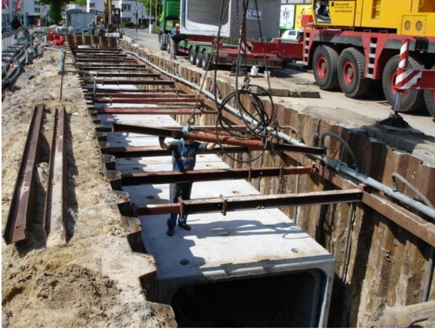
Bereits zu 50% fertiggestellter Stauraumkanal
